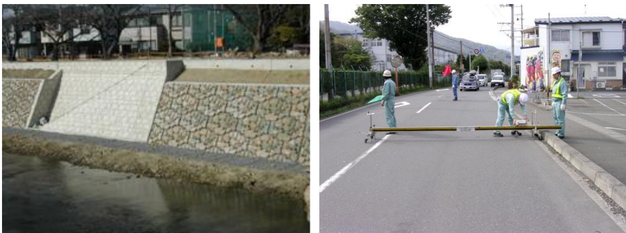
図 3.2 エコスラグの使用例 (左：河川工事、右：路盤工事)
