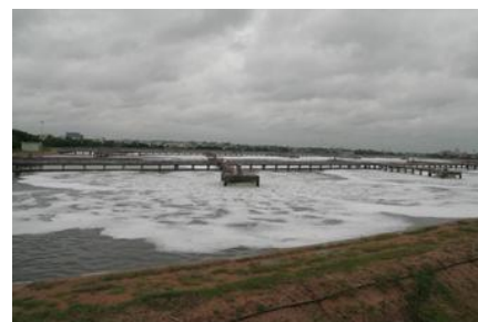
③下水処理施設の曝気槽（インド）
